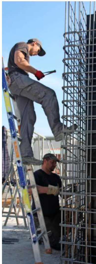
Der Aufzugsschacht wird fürs Betonieren vorbereitet.
